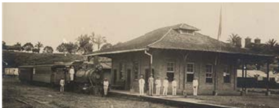
A ferrovia nacionalizada em 1931. Na imagem, estão dois símbolos de Porto Velho: a Mad Maria (apelido dado pelo ilustre escritor amazonense Márcio Souza ao trem de ferro) e as Três Caixas (no fundo da imagem, à direita) (Foto: Acerco do Arquivo Nacional)
