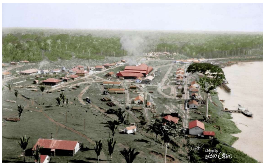
FIGURA 1 - Aspecto do complexo ferroviário da E.F.M-M e suas principais edificações, em 1911.
